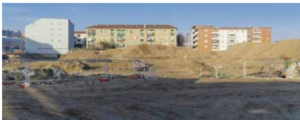
Via Frigia 19, Villa San Giovanni, i lavori di sbancamento dopo il taglio del boschetto spontaneo
